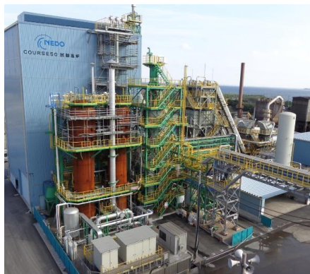
12m 3 小規模試験高炉(水素還元)
