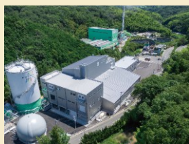
縦型乾式メタン発酵施設
