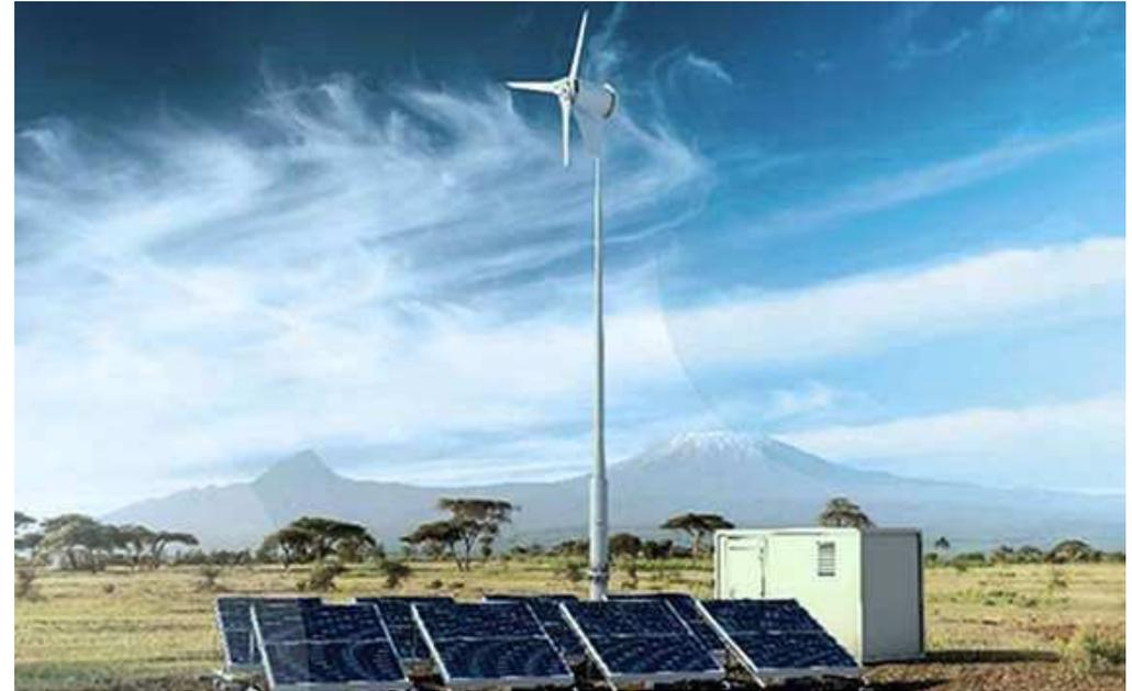
出力 **6 kw** のダウンウインド型小型風車
