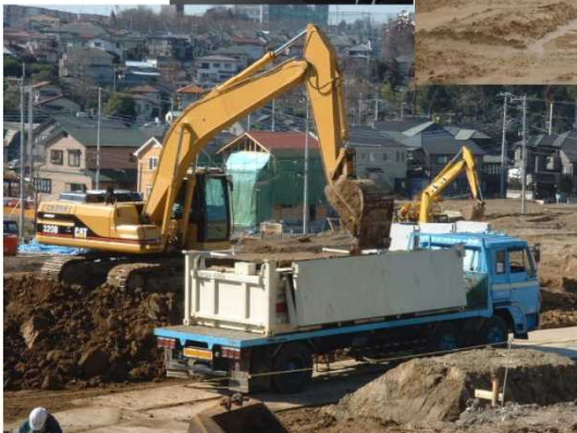
掘削現場での発生土の積み込み
