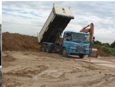
ダンプアップによる土砂の取卸し
