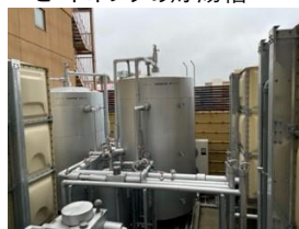
<太陽熱蓄熱層とヒートポンプの貯湯槽>
