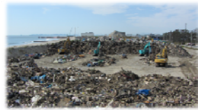
一次仮置き場での機械粗選別
