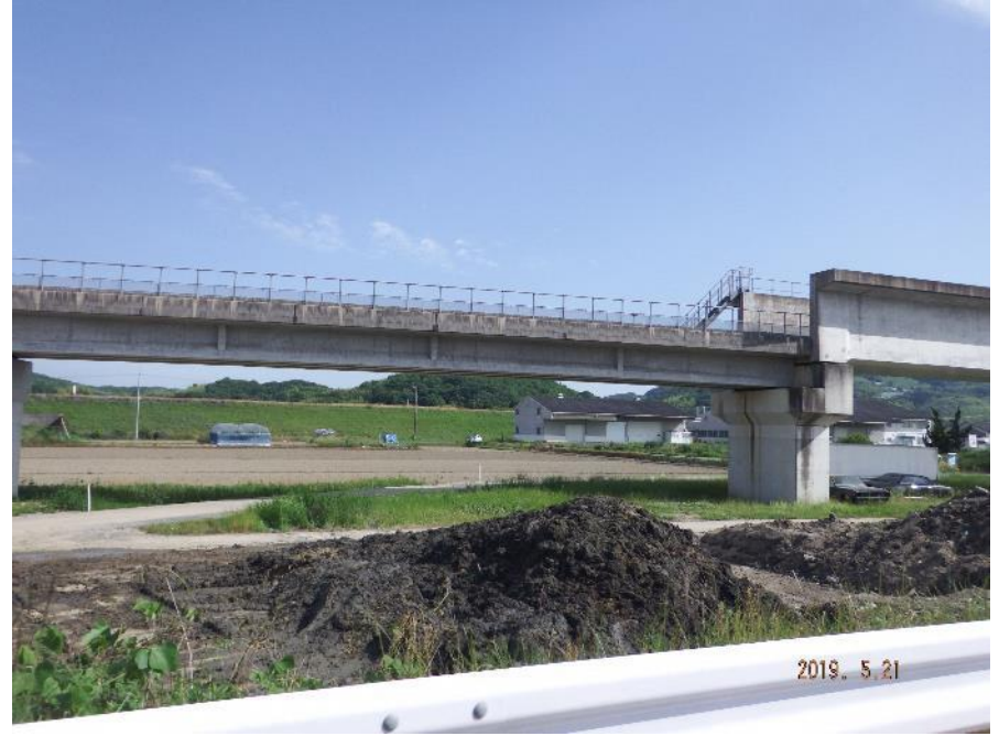
高架下（撤去後）
