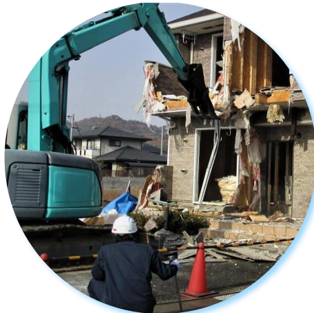
公費解体の実施
