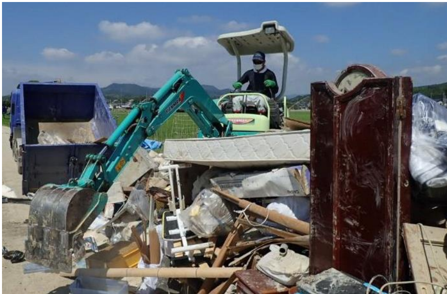
建設業協会による撤去作業
