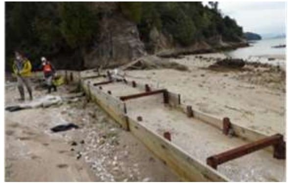
【二ヶ所目の作業前の状態】
