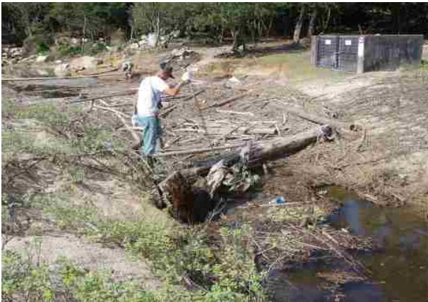
作業前(流竹木堆積)(写真:河野)
