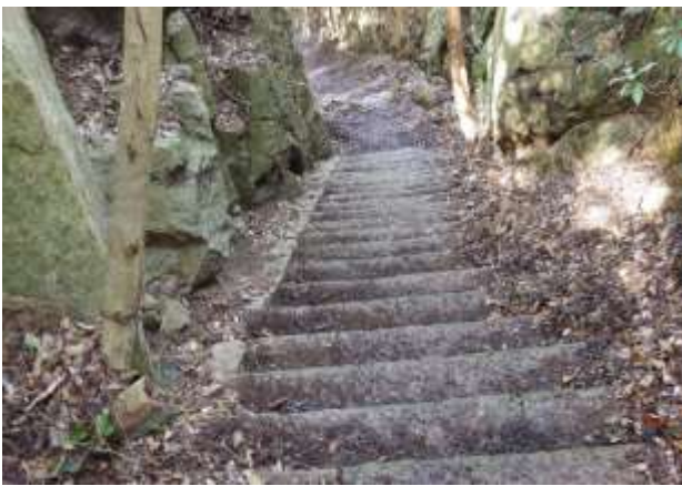
方位観測所の階段(清掃後) ( 文, 写真 : 河野 )
