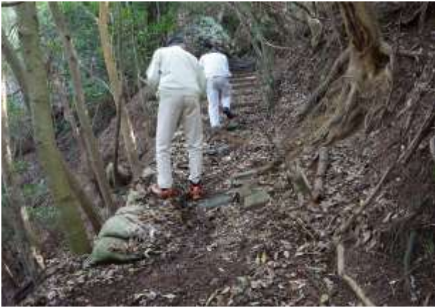
方位観測所の階段の清掃作業
