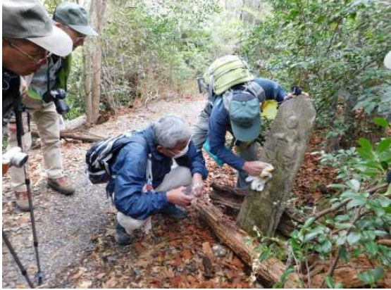
奥の院二十七丁町石の点検作業(岩崎)
