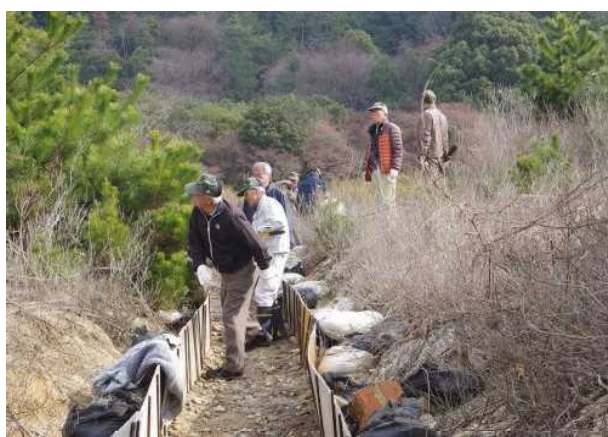
水路整備 流水なし
