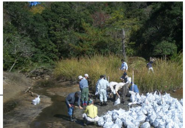
水路の土砂除去、土のう積み
