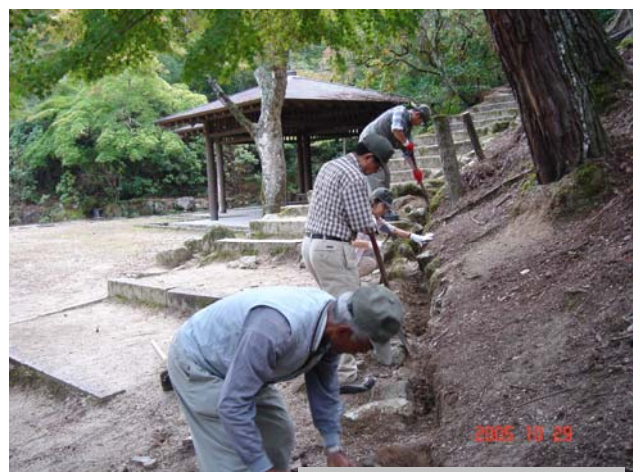
側溝の土砂除去作業
