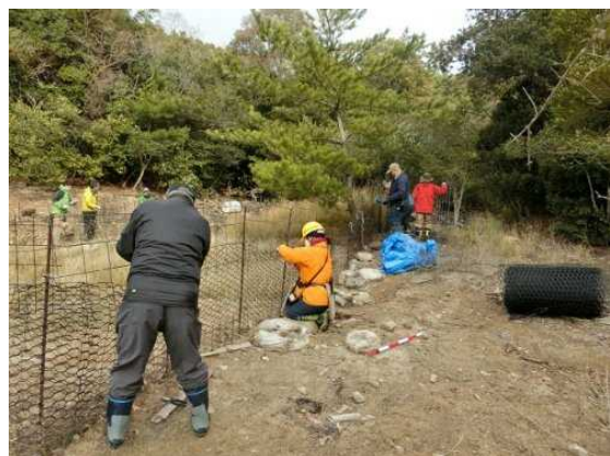
上部ネット取付け作業
