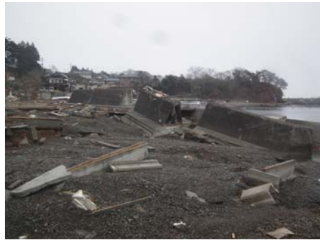
全壊した防潮堤
