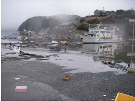
沈下した漁港
