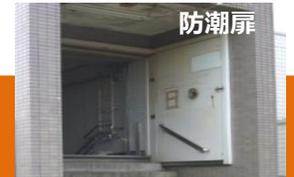
地下鉄出入口の浸水対策
