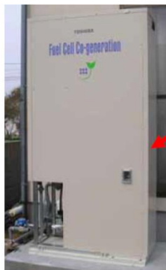
一般家庭に設置された水素供給燃料電池（貯湯タンク型）
