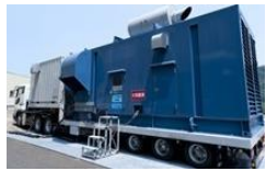
空冷式非常用発電装置の設置
