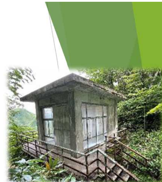
【室の内展望所の解体撤去】
