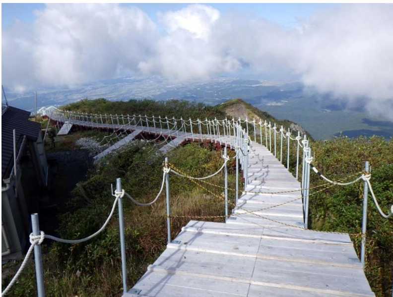
頂上付近の木道改修を実施
