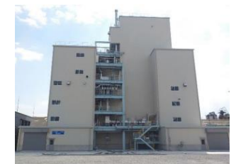
実証試験設備の外観
