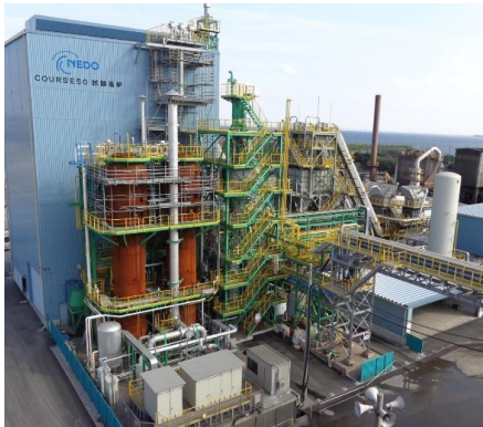
12m 3 小規模試験高炉(水素還元)
