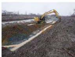
河道掘削 (石狩川水系、北海道開発局)
