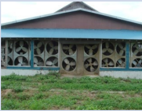
畜舎壁面の換気扇
