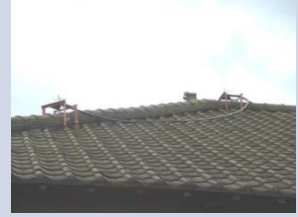
畜舎屋根へのスプリンクラー設置
