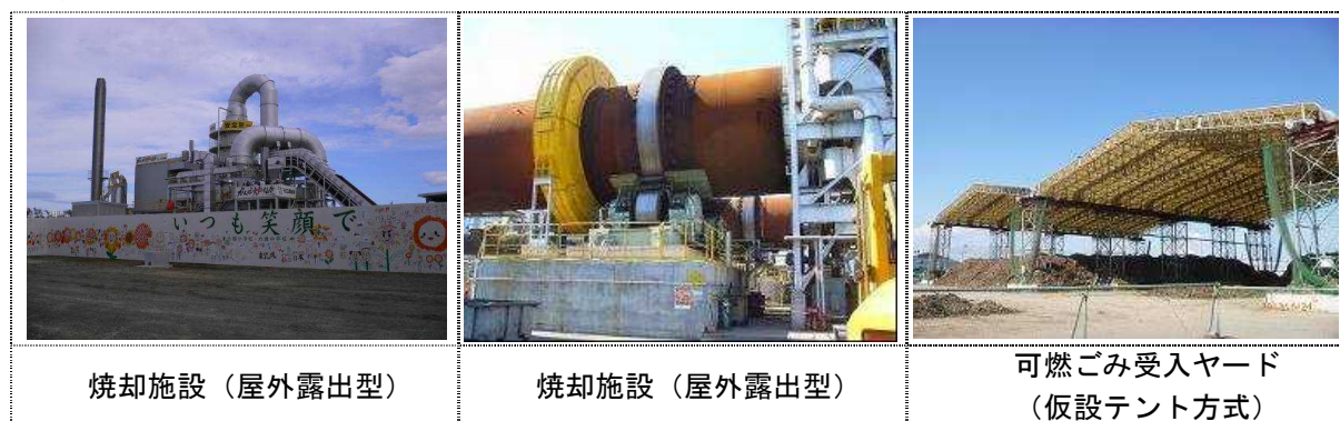
仮設焼却処理施設例（宮城県・仙台市の例）
