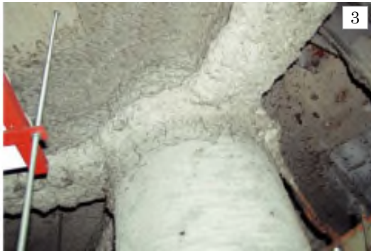
吹付石綿(鉄骨耐火、被覆材):レベル 1
