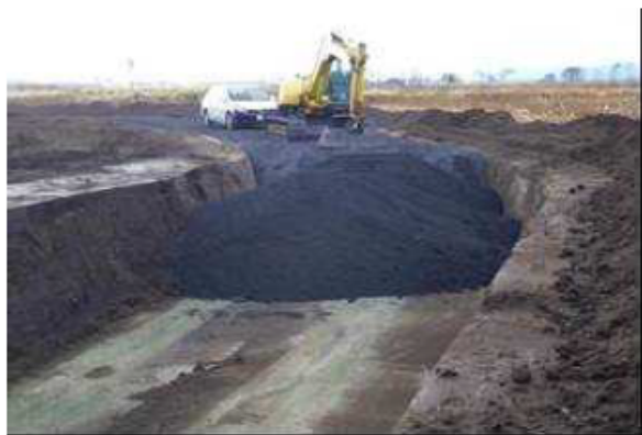
焼却灰造粒固化物（中央の黒っぽい土）、津波堆積物からの再生資材（横の土壌）のサイクリングロードへの利用 宮城県名取市
