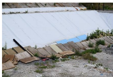
遮水シート保護材の廃置
