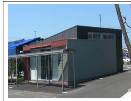
《学習棟の外観》
