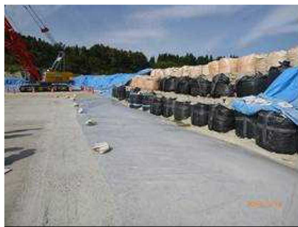
土壌層敷設後の飛灰の埋立作業
