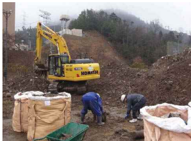
2 中国電力南原研修所多目的グラウンド 【H27. 2.26 作業風景】
