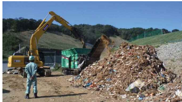
写真 1-2-5 玖谷埋立地内の移動式破砕機
