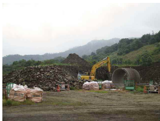
4 広島市有地(市立大学側) 【H27.9.7 作業風景】
