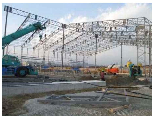
【H27.1.11 仮設テント設置工】
