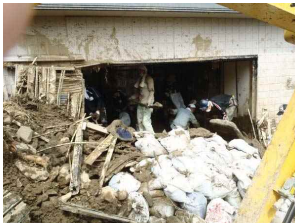
写真 1-5-2 ボランティアによる土砂等撤去
