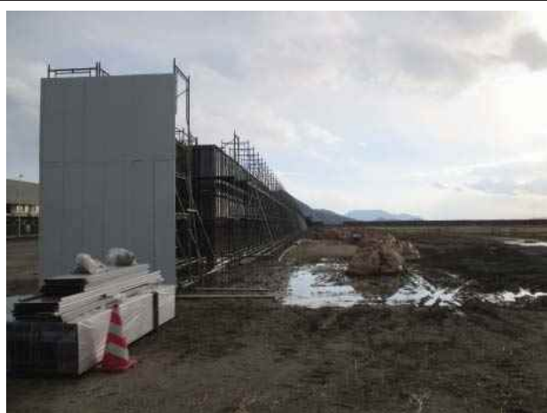
【H27.12.22 仮囲い設置工】
