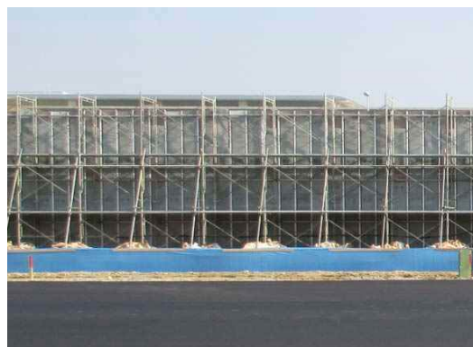
写真 3-5-25 防音対策を講じた仮囲い
