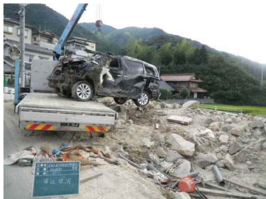
写真 3-4-5 被災地から搬出される廃自動車
