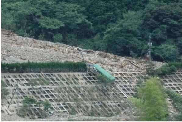
写真 1-1-7 宇津し尿中継地被災状況
