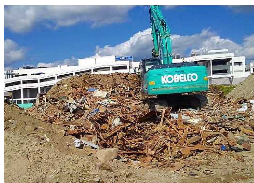
写真 2-1-2 がれき混じり土砂等の 処理の様子
