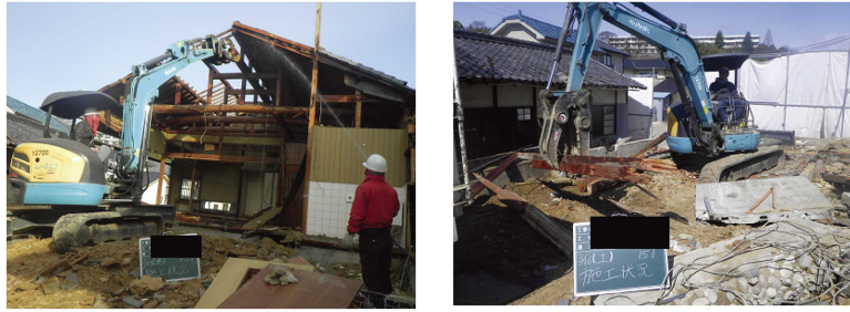
写真 2-9-4 被災家屋の解体・撤去の状況
