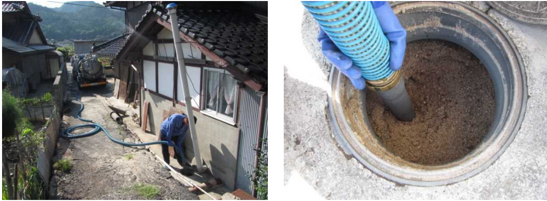
写真 2-6-1 土砂等が流入した汲み取り便槽の特別収集状況
