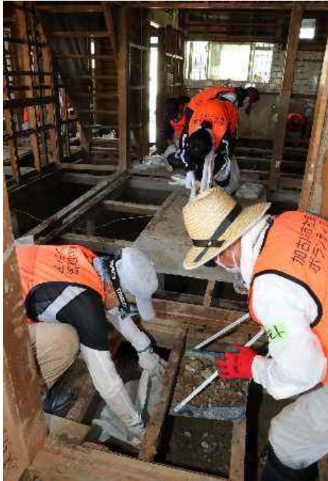
床板や壁材の撤去と汚泥の除去
