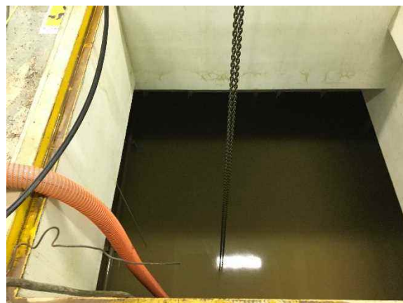
H30.7.11 地下ポンプ室 地下ポンプが水没している
