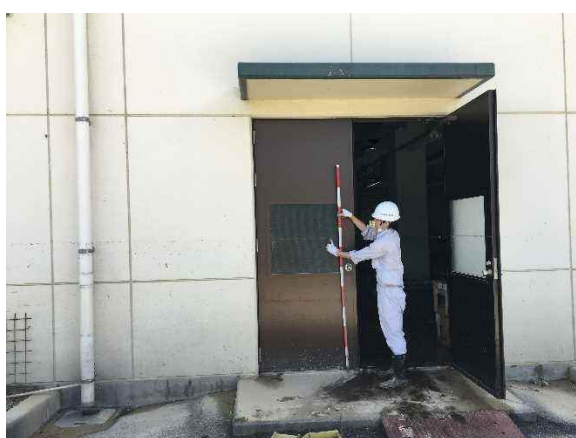
H30.7.9 処理水槽室の扉 職員が浸水した床面から 130 cm の位置を示している
