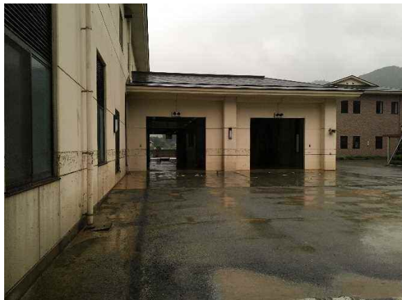
H30.7.8 受け入れ室の自動扉 被災により誤作動が起き自動扉が全開の状態
