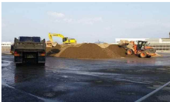
写真 3-5-22 分別土砂保管ゾーン
