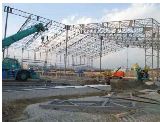
【H27.1.11 仮設テント設置工】
