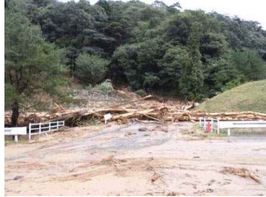
写真 1-1-8 玖谷埋立地被災状況
