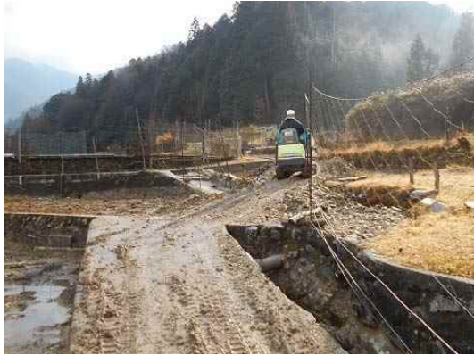
写真 2-4-1 民有地からキャタピラ式小型ダンプ車での撤去状況
