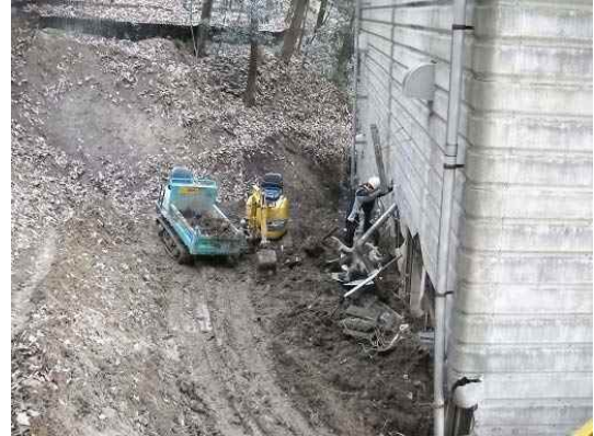
写真 2-4-1 民有地からキャタピラ式小型ダンプ車での撤去状況
