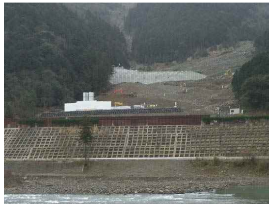
写真 1-2-8 宇津し尿中継地 (平成 28 年 2 月撮影)
