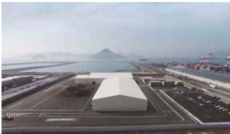
写真 3-5-1 災害廃棄物中間処理施設
