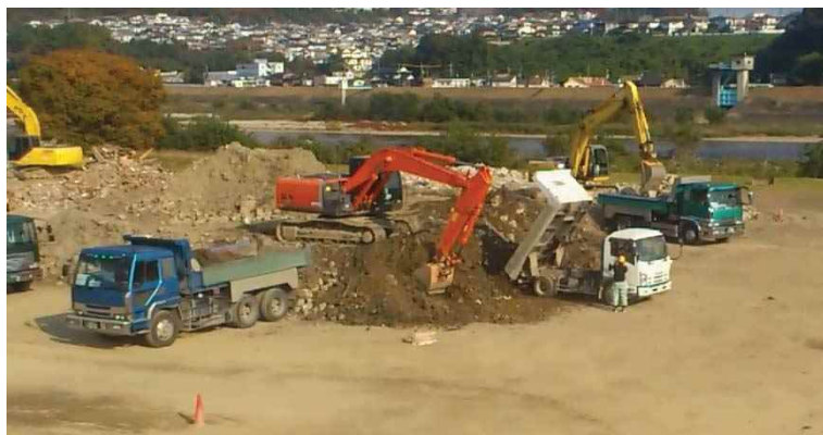
写真 1-1-10 太田川河川敷の積替場
