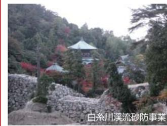
平成17年9月の台風14号で、白糸川上流の駒ヶ林の山腹斜面が崩壊し、大規模な土石流が発生しました。この土石流により、大聖院をはじめとした多くの文化財が被災しました。復旧のための砂防工事では、現地発生した石材や掘削土を骨材として使用する工法など、地形の改変や周辺環境への影響を最小限に抑え、宮島らしい景観に配慮した整備を行いました。工事は平成20年10月に完成し、弥山登山道・大聖院コースも約3年ぶりに開通しました。
