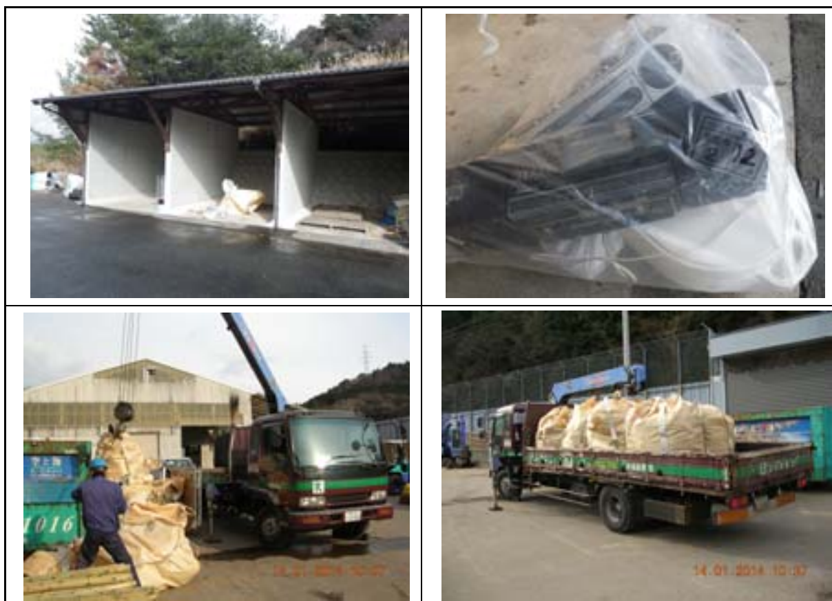
東温市 集積・収集運搬（車両積み込み状況）
