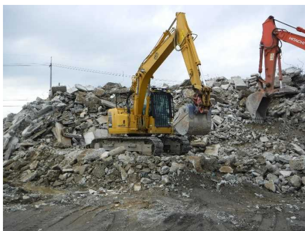
仮置場で土砂とがれき類に分別している様子
