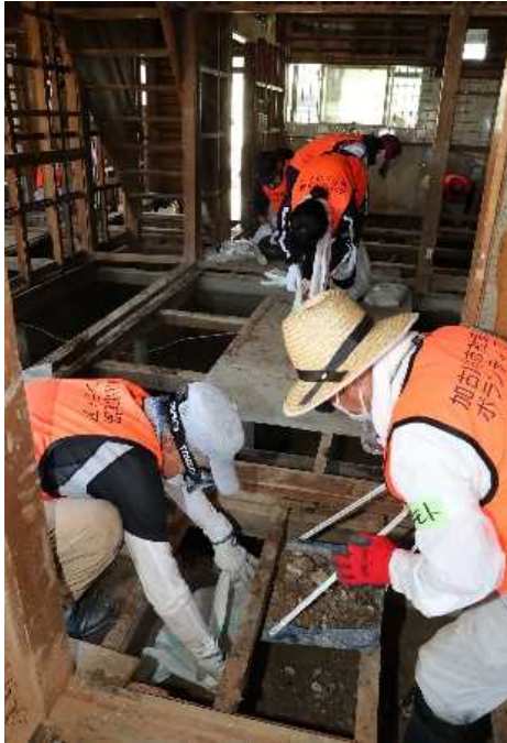
床板や壁材の撤去と汚泥の除去
