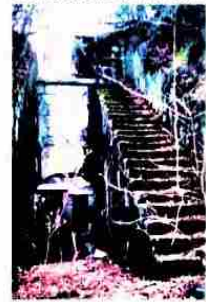
南部探照灯砲台跡
