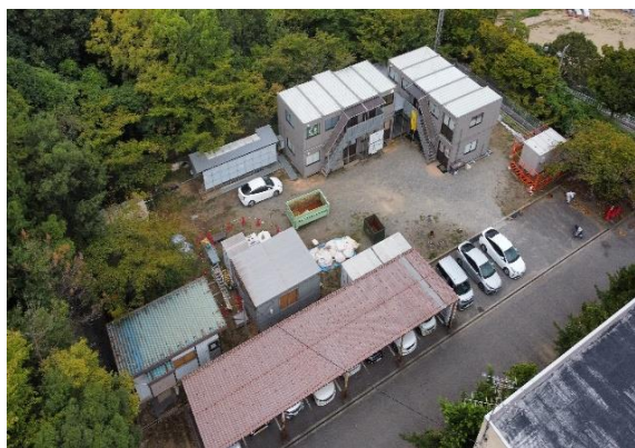
施工業者の現場事務所用地
