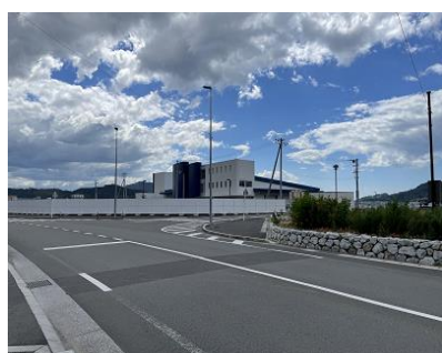
県道からの出入口付近の様子
