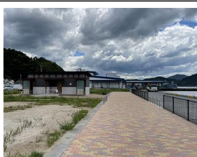
敷地内にあるトイレ
