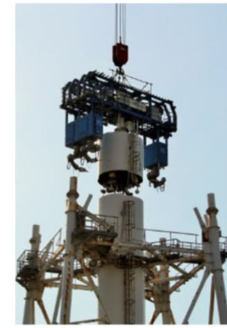
遠隔による解体作業
