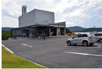
駐車場から見る清掃工場
