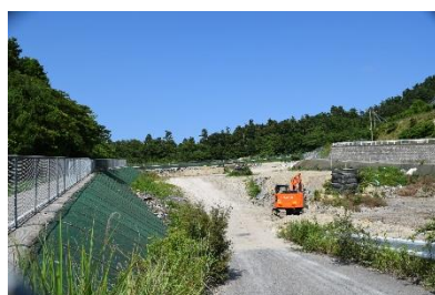
最終処分場入口
