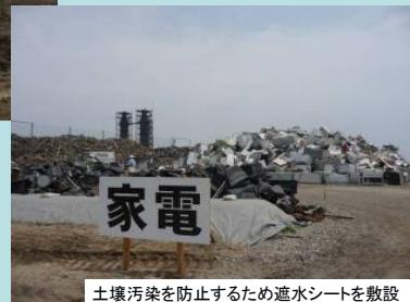
土壤汚染を防止するため遮水シートを敷設
